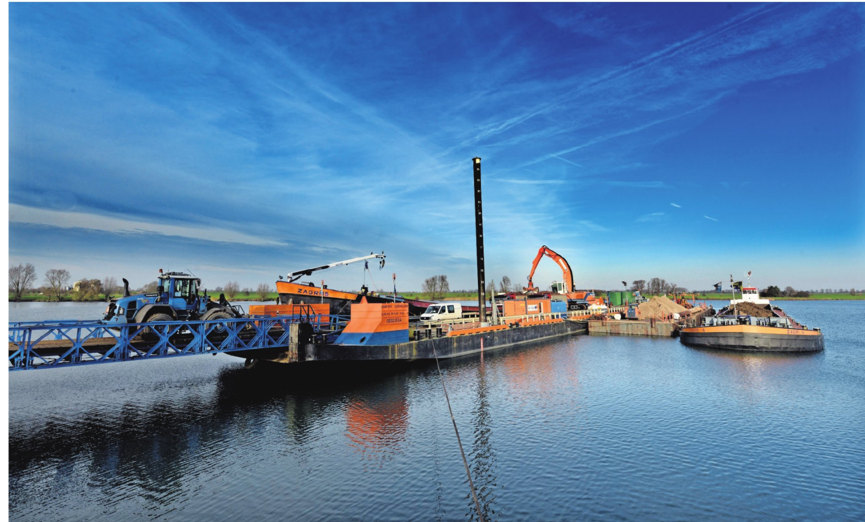
◀ Werkzaamheden bij de Redichemse Waard in Culemborg. Baggerbedrijf Van Waning wil hier licht vervuilde grond uit Parijs storen.
